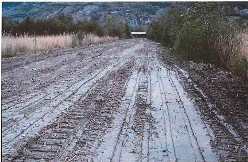
Abb. 14: Einbau Feinmaterial aus dem Grossgrundkanal im Zwischenbereich der 300 m-Schiessanlage in Mutt, Photo P. Werner, 1992.
